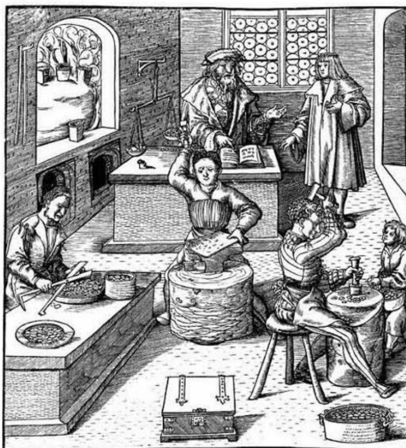
Rys. 1.4.5. Warsztat menniczy na szesnastowiecznej grafice, w piecu po lewej widoczne są tygły do topienia metalu, pośrodku siedzi pracownik rozklepujący blachę, z lewej – obcinający nożycami krążki men-nicze. Z prawej siedzi mincarz wybijający monety z gotowych krążków podawanych przez pomocnika. Na drugim planie władca stojący obok probierza (wardajna) sprawdzającego na wadze monety, źródło: Wikipedia
