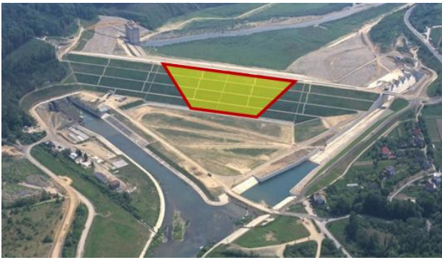
III. 6. Beispielhafte Lokalisationen von Stellen der Entstehung von Beschädigungen des Korpus des Erddamms bei Überlaufen des Wassers über die Krone bzw. bei hydraulischem Durchbruch (Świnna Poręba).
