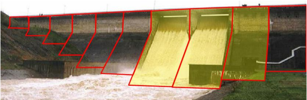
Rys. 7. Przykładowe lokalizacje uszkodzonych sekcji korpusu zapory betonowej w wyniku utraty stateczności podłoża (Besko).
