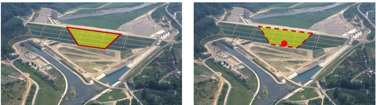
Rys. 6. Przykładowe lokalizacje miejsc powstania uszkodzeń korpusu zapory ziemnej w przypadku przelania wody przez koronę lub przebicia hydraulicznego (Świnna Poręba).
