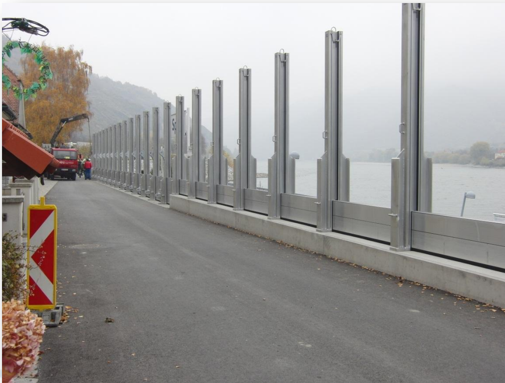
budowa próbna Spitz
